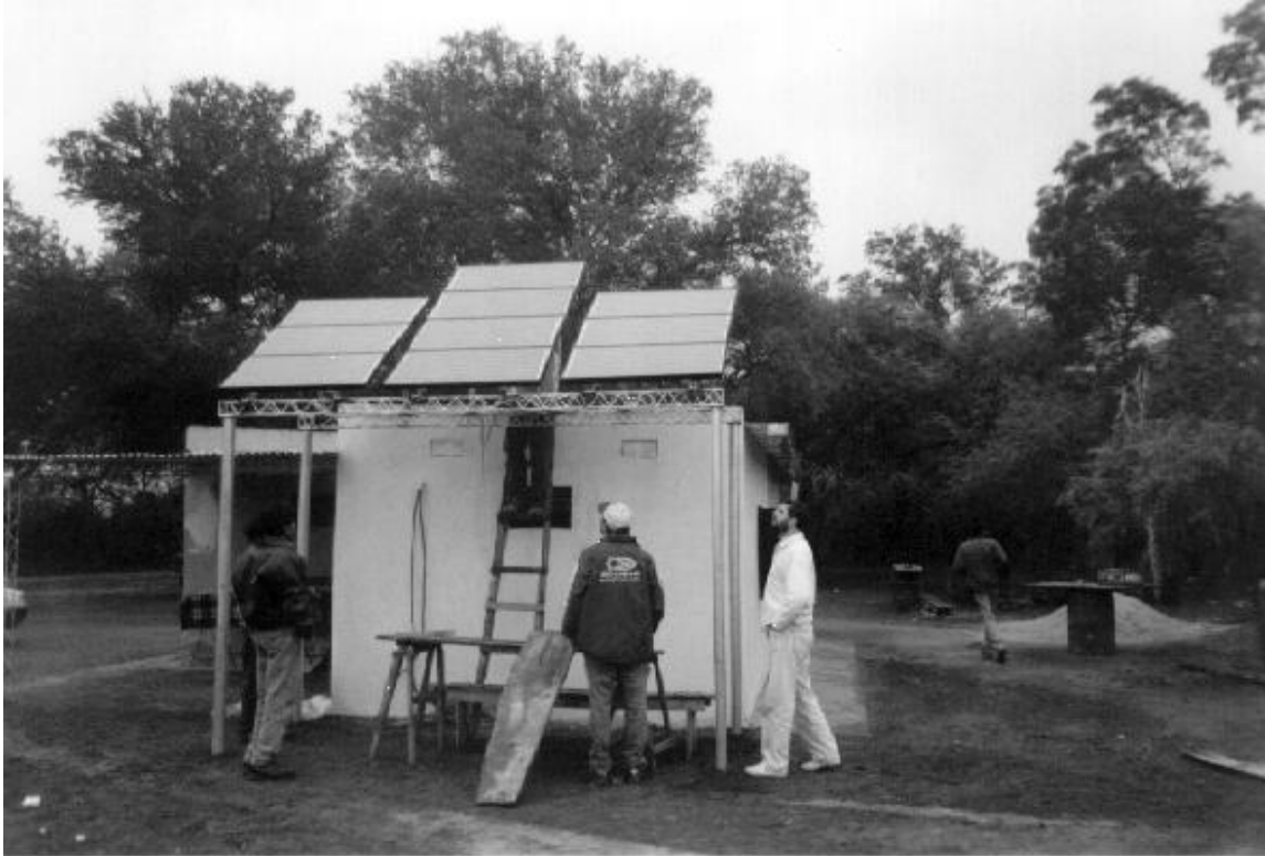
Fig. 1: Un momento en la instalación de los paneles fotovoltaicos
