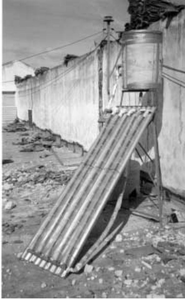
Fig.1.- Vista del montaje del calefón solar.
