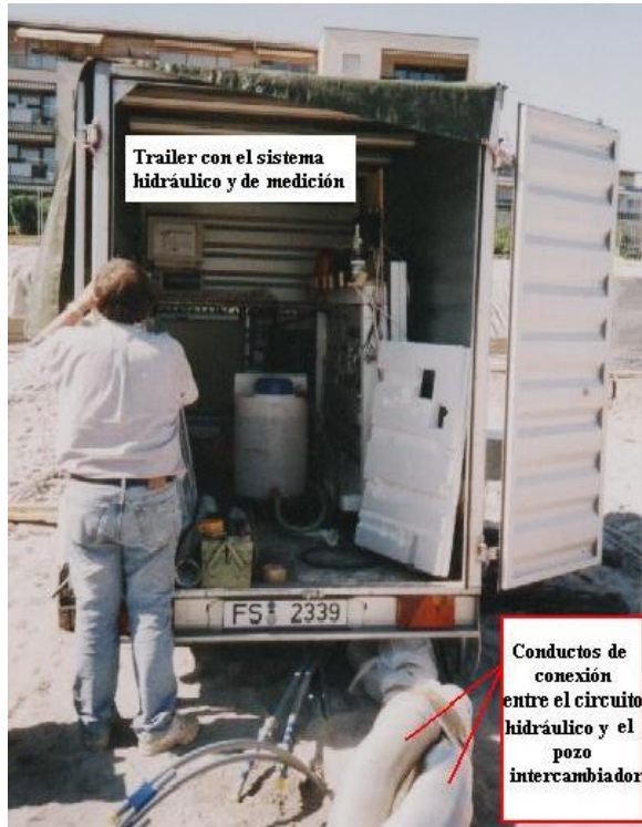
Figura 2.- Sistema de medición y conexión al pozo intercambiador.
