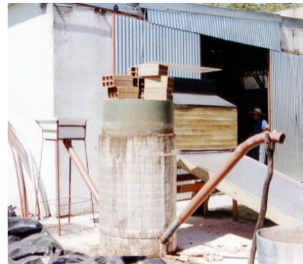
Figura 12.- Vista del biodigestor.
